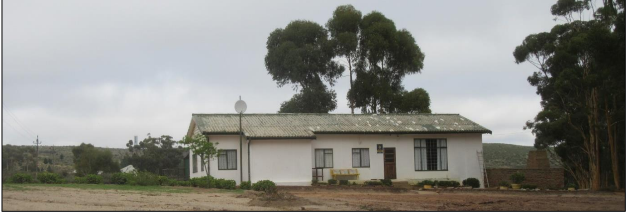
Photograph 3.10: Sandvlei Kuierhuis guest accommodation on Eendracht 38/1
